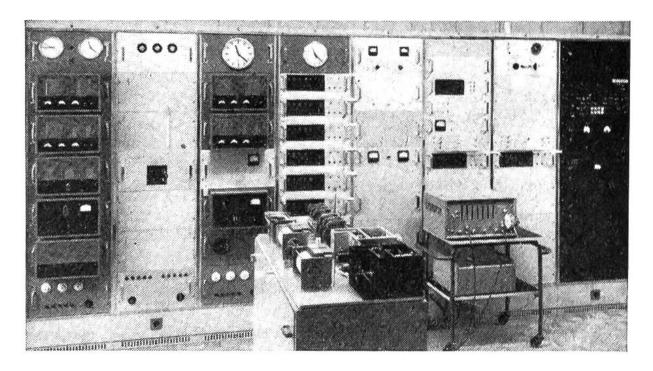
Gesamtansicht der Anlage zur Erzeugung und Abgabe der Zeitzeichen und Frequenzsignale im Observatorium Neuenburg. In den Schränken im Hintergrund sind die Geräte eingebaut, welche die elektrischen Frequenzen 1000, 100, 10 und 1 pro Sekunde sowie die Tonfrequenzen 1000 Hz und 1250 Hz herstellen. Im Vordergrund ist der mechanische Teil der Zeitsignalanlage zu sehen.
