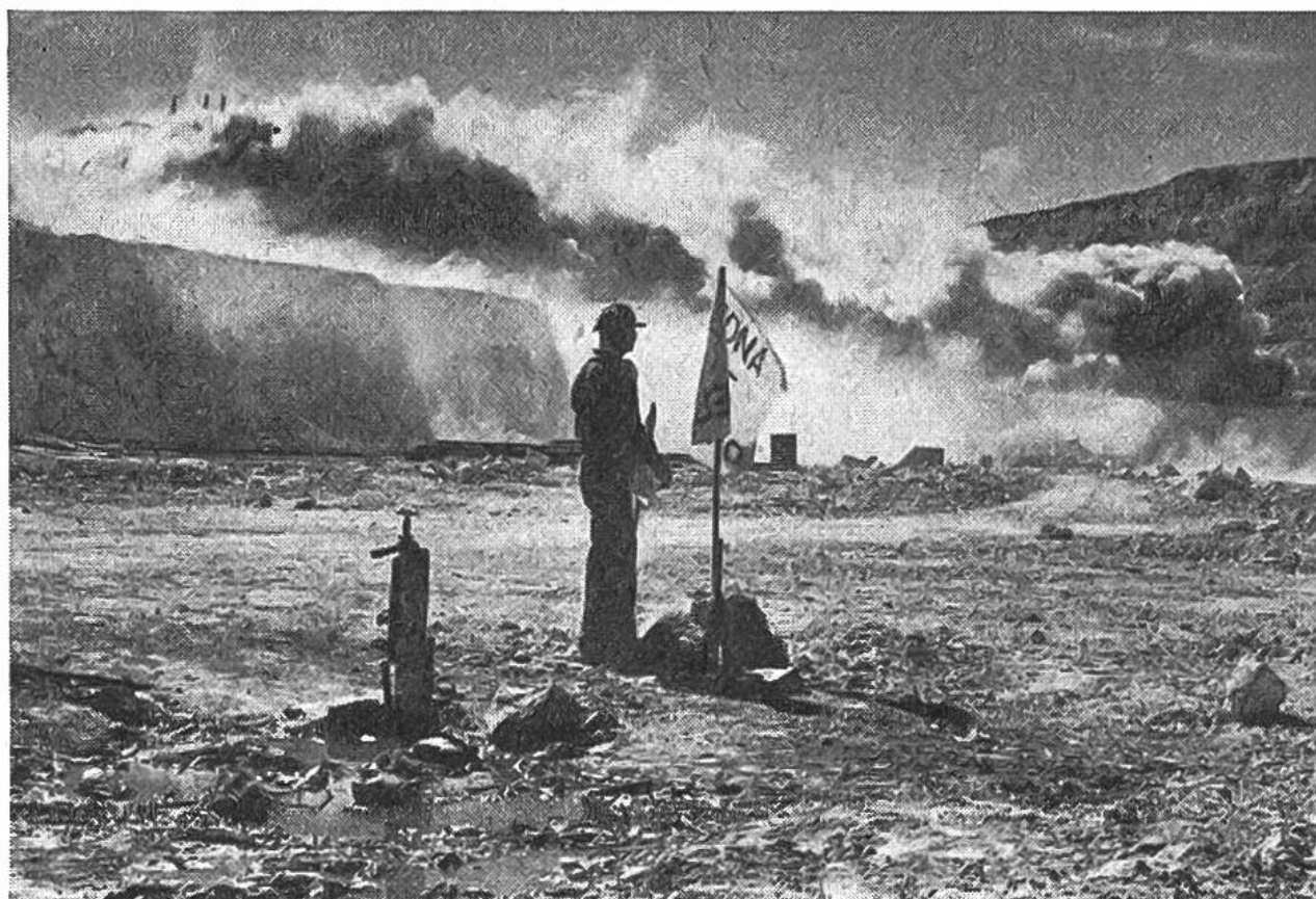
Das kupferhaltige Gestein wird losgesprengt.
