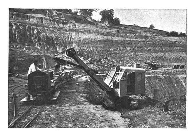
Der Lehm wird in der Grube schichtenweise mit dem Bagger abgebaut.
