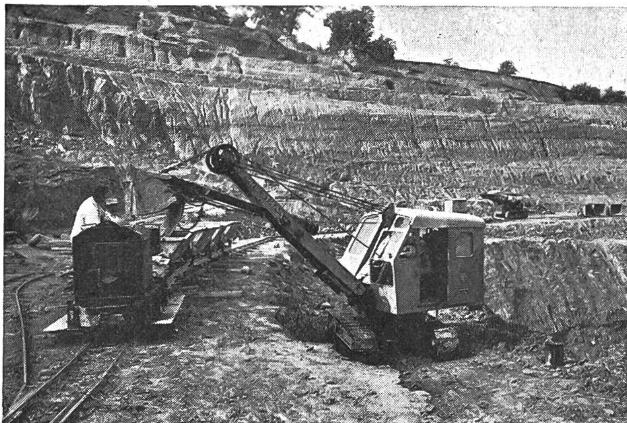
Der Lehm wird in der Grube schichtenweise mit dem Bagger abgebaut.
