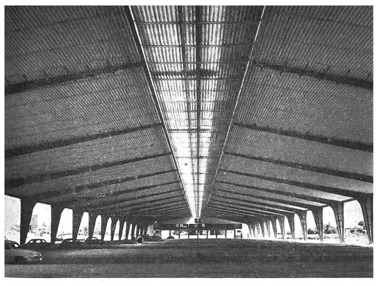
Innenansicht einer weitgespannten Markthalle. Die Breite beträgt 62 m, die Länge 153 m und das gesamte Stahlgewicht 400 Tonnen. Damit eine gute Belichtung vorhanden ist, sind in der Mitte Oberlichter eingebaut, welche das Tageslicht durchlassen. Die Halle war in vier Monaten aufgestellt.
