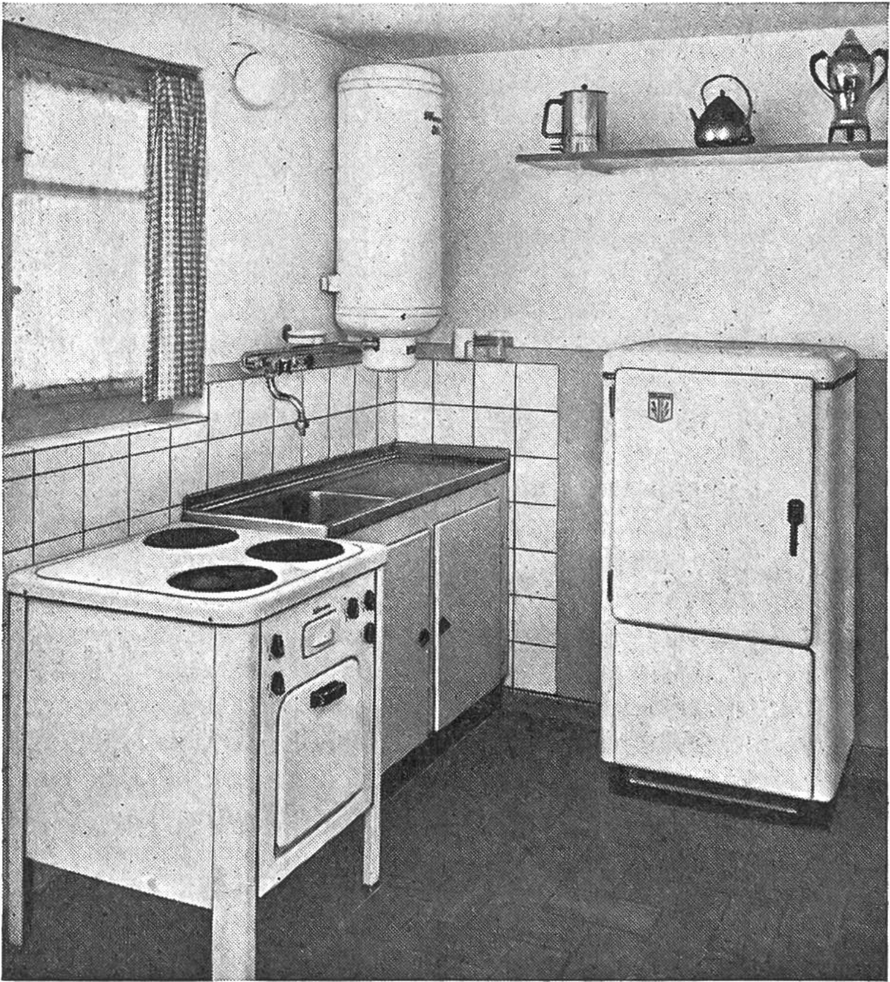
Küche 3: Vollelektrische Haushaltküche aus den vierziger Jahren.
