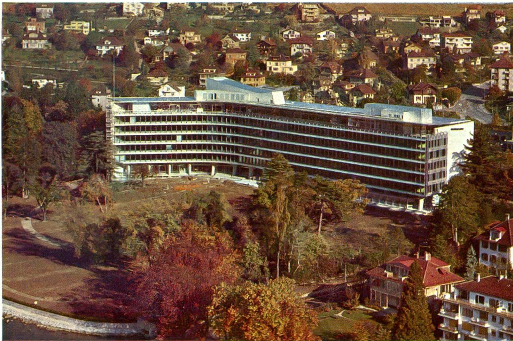
Verwaltungsgebäude der Nestlé Alimentana AG., in Vevey, erbaut 1960 unter Verwendung von 250 t Aluminium für Bedachung, Fassadenverkleidung, Fensterrahmen, Storen, Trennwände, Türen, Treppenverkleidungen.
