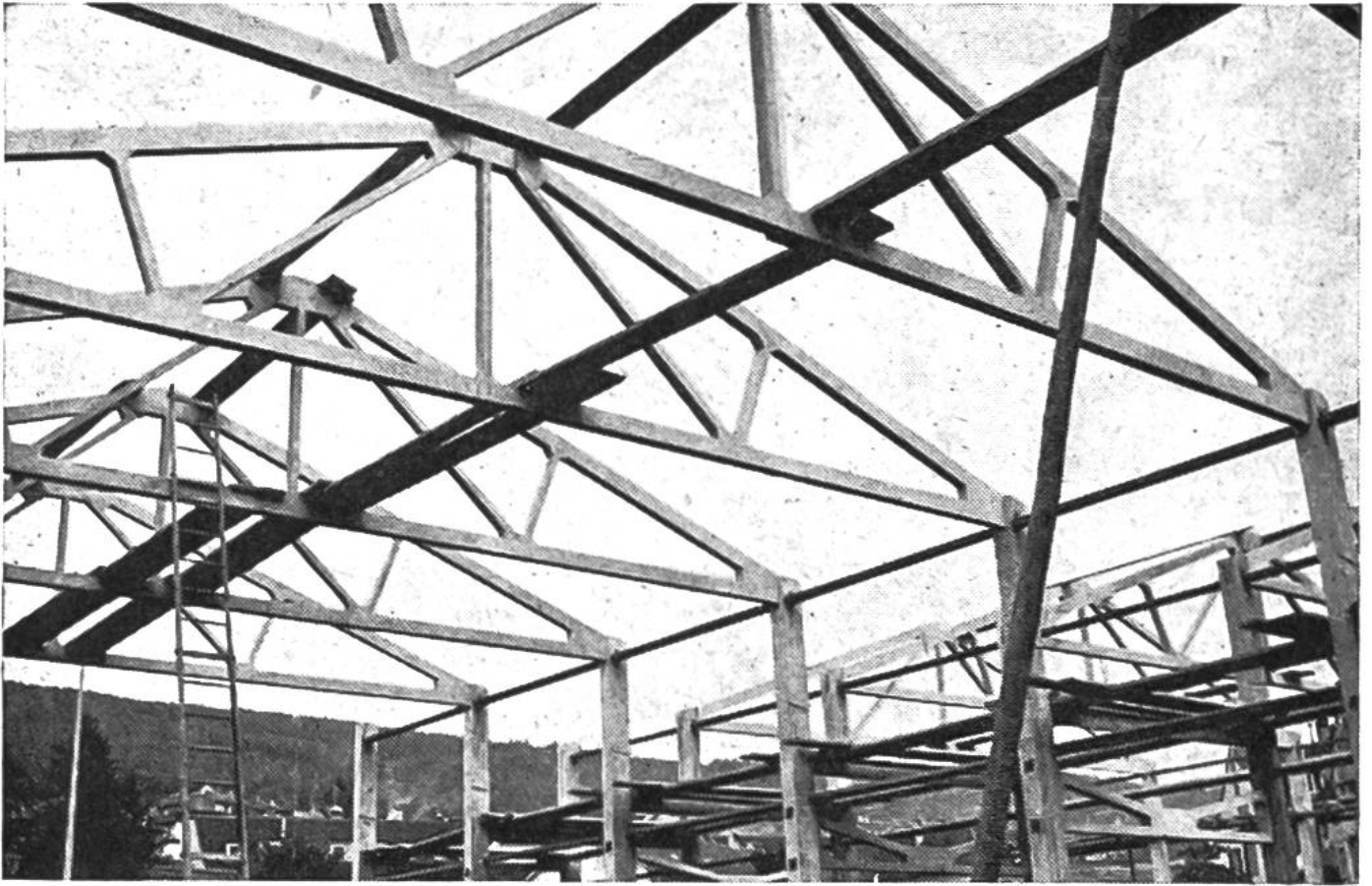
Hallenkonstruktion aus vorgefertigten Betonelementen.
