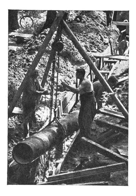
Bei der Wasserversorgung hat sich das «Eternit»-Druckrohr in wenigen Jahren erfolgreich durchgesetzt, weil es leicht, widerstandsfähig und einfach zu verlegen ist.
