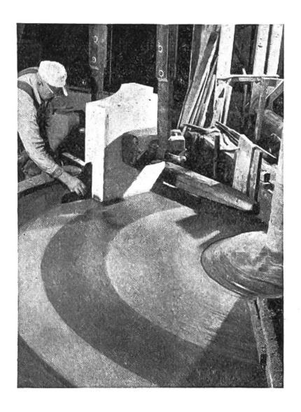
Steinschleifer schleift Marmor auf einer rotierenden Platte.
