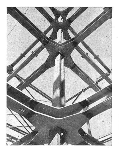
Warenhaus Jelmoli in Zürich-Oerlikon. Aus mächtigen Stahlprofilen ist eine Stütze zusammengeschweisst worden, bei welcher die Deckenunterzüge sternförmig zusammenkommen.
