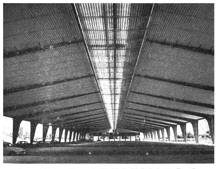
Innenansicht einer weitgespannten Markthalle. Die Breite beträgt 62 m, die Länge 153 m und das gesamte Stahlgewicht 400 Tonnen. Damit eine gute Belichtung vorhanden ist, sind in der Mitte Oberlichter eingebaut, welche das Tageslicht durchlassen. Die Halle war in vier Monaten aufgestellt.
