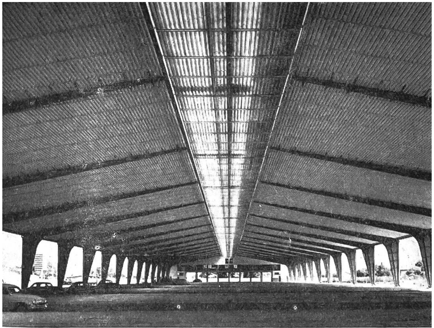
Innenansicht einer weitgespannten Markthalle. Die Breite beträgt 62 m, die Länge 153 m und das gesamte Stahlgewicht 400 Tonnen. Damit eine gute Beleuchtung vorhanden ist, sind in der Mitte Oberlichter eingebaut, welche das Tageslicht durchlassen. Die Halle war in vier Monaten aufgestellt.
