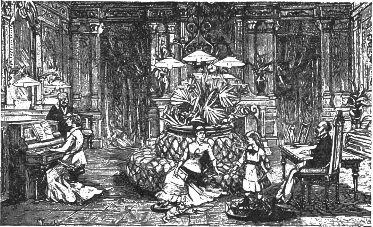
Salon einer New Yorker Familie, der als eines der ersten Privatzimmer mit elektrischen «Edison»-Glühlampen beleuchtet wurde. Charakteristisch ist bereits die «Arbeitsteilung» der Lampen; die drei mittleren dienen der Allgemeinbeleuchtung des Raumes, während die beiden Lampen über dem Klavier als reine Arbeitsplatzbeleuchtung angesprochen werden.
