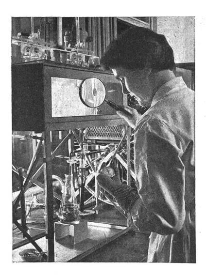
Mit dieser Apparatur wird geprüft, ob ein Waschmittel die Gewebe schont.
