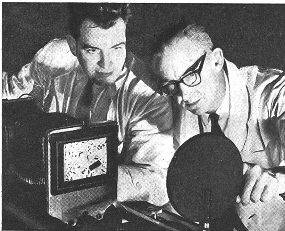
Untersuchung eines Legierungsschliffs auf dem Metall-Mikroskop.
