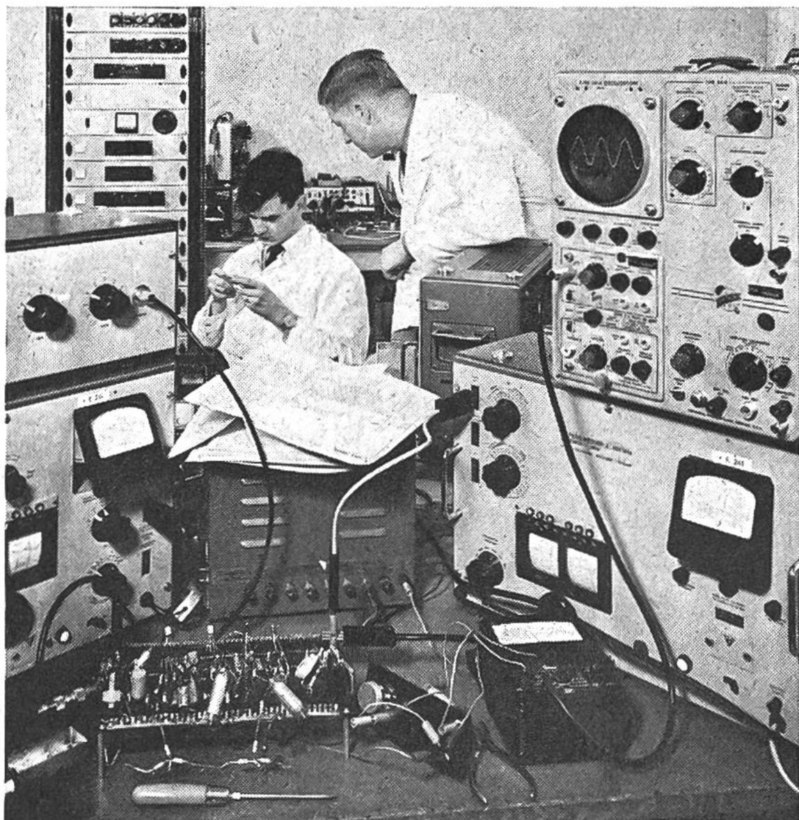
Ein erster Versuchsaufbau eines Verstärkers für die Trägerfrequenz-Telephonie wird geprüft. Als Verstärkerelemente dienen Transistoren, die kleiner als ein Kubikzentimeter sind. Im Hintergrund ein Gestell mit Röhrenverstärkern herkömmlicher Bauart.
