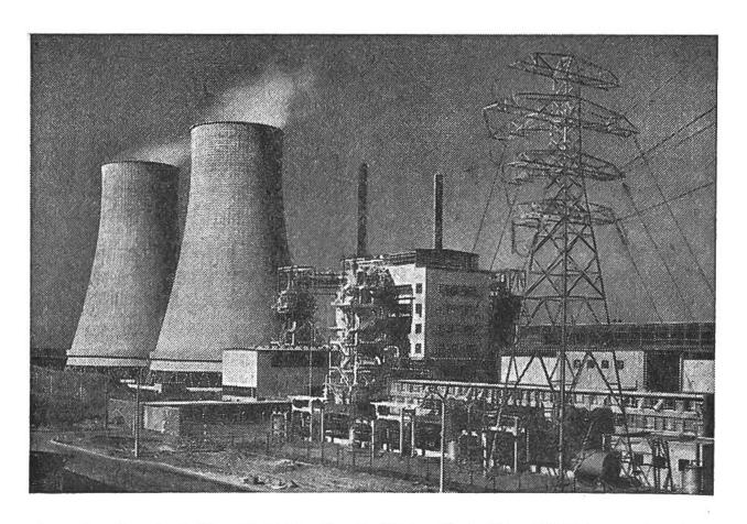
Atomkraftwerk Calder Hall (England). Links die beiden Kühltürme, daneben der Reaktor mit den vier Wärmeaustauschern.
