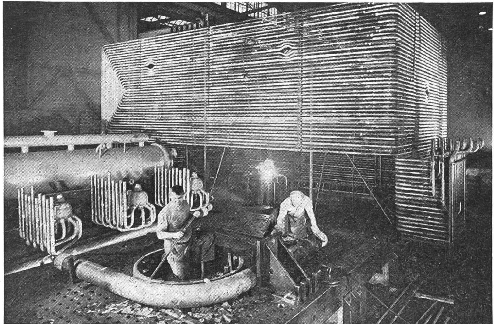
Im Jahre 1929 haben Gebrüder Sulzer eine ganz neue Kesselbauart entwickelt: den Einrohrdampferzeuger. Er besteht im Prinzip aus einem fortlaufenden Rohrstrang von grosser Länge und besitzt keine Kesseltrommel mehr. Er wird für höchste Drücke und Temperaturen gebaut. Die grössten bisher gebauten Einrohrdampfkessel erzeugen bei einem Betriebsdruck von 372 Atmosphären stündlich 907 Tonnen Dampf von  $654^{\circ}$  C.
