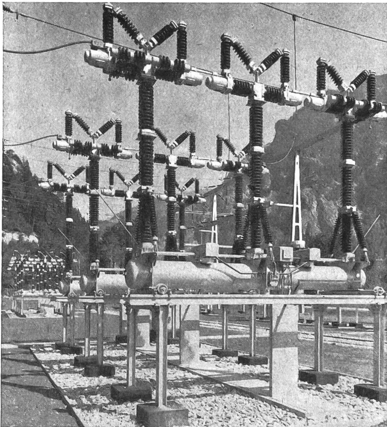
Die schlanken Gebilde, die sich, äusserlich betrachtet, aus gerillten Porzellansetzern zusammensetzen, gehören zu den drei nebeneinander stehenden Polen eines Brown Boveri Druckluftschnellschalters für eine Spannung von 200000 V in einem Leitungsabgang der Zentrale Rothenbrunnen der Kraftwerke Zervreila AG, Vals (Graubünden). In den liegenden Behältern ist die zum Löschen des Schalterlichtbogens nötige Druckluft aufgespeichert.
