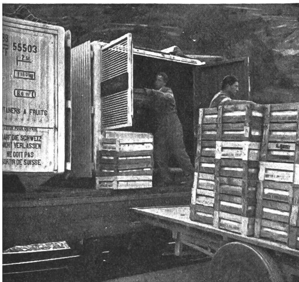
Verlad von Walliser Erdbeeren in Früchtebehälter, die isolierte Leichtmetallwände und weissgestrichene Holzroste als Sonnenschutz-Verkleidung haben.
