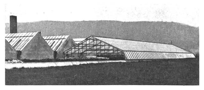
Das grosse, quergestellte Glashaus ist ein sogenannter «Rollblock», der auf Schienen und Rollen seiner ganzen Länge nach verschoben werden kann. Diese Konstruktion ermöglicht es, das kostbare Glasdach jeweils über diejenigen Pflanzenkulturen zu bringen, die den Schutz am nötigsten haben, während andere Kulturen auf der nicht bedachten Fläche abgeräumt oder vorbereitet werden.
