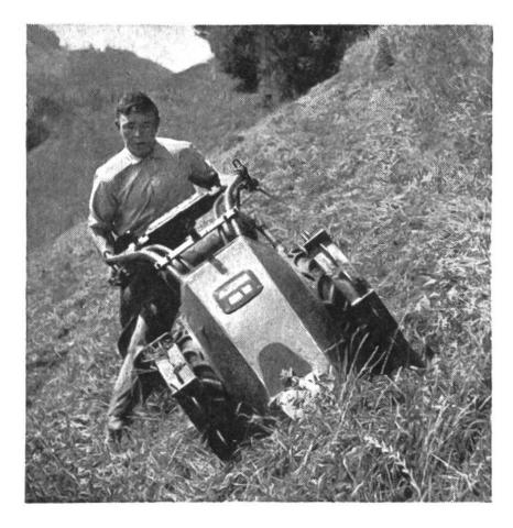
Motormäher mit tiefer Schwerpunktlage am Steilhang. Hier wurde bis vor kurzem mit der Sense gemäht. Der Mann leistet mit dem Motormäher soviel wie 6 kräftige Mähder.
