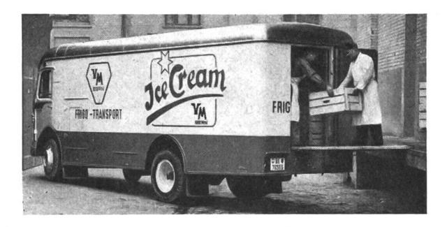
4. Tiefkühlwagen für den Transport von Ice Cream. Das Fassungsvermögen beträgt 50 000 Portionen. Die eingebaute Kühlmaschine (vorn) ermöglicht eine Dauertemperatur des Laderaumes von minus 20° C. Der Antrieb des Kühlaggregates erfolgt am Standort elektrisch, während der Fahrt durch einen besonderen Benzinmotor. (Verbandsmolkerei Bern GmbH.)
