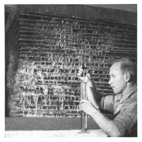
Köstliche Ströme von Obstsaft fliessen! Aus den zu Mus vermahlenen und zwischen feste Tücher gepackten Früchten wird mittels der hydraulischen Presse der Saft gewonnen. Der Moster kontrolliert mit Hilfe der Oechslewaage den Zuckergehalt des Saftes. (Photo Ernst Brunner, Luzern).
