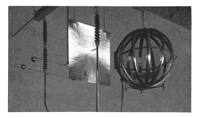
Links: Versuch zur Ermittlung des Einflusses einer Glasplatte zwischen zwei Spitzen: Die Entladung erfolgt um die Platte herum!
