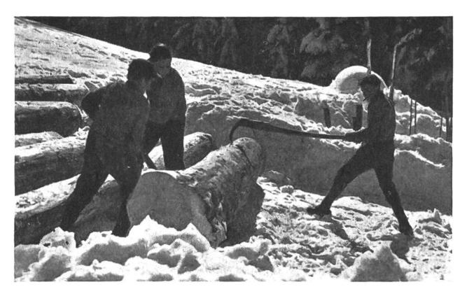
Verladen von Trämeln mit Hilfe von Sparren, Kehrhaken und «Zapi» (rechts).
