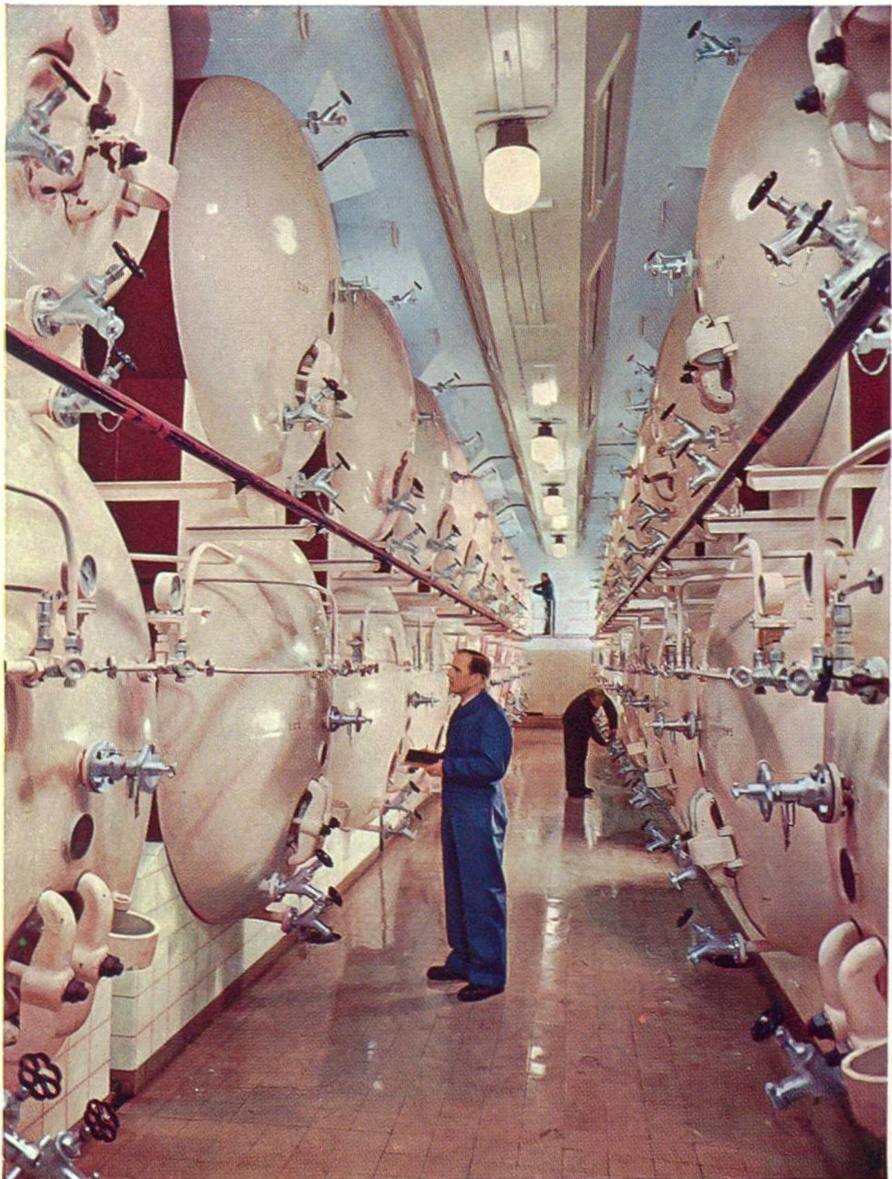
1 000 000 Liter Süssmost lagern in diesen Stahltanks! Bei 0° C und 3,5 Atmosphären Kohlensäuredruck ist die Haltbarkeit garantiert.
