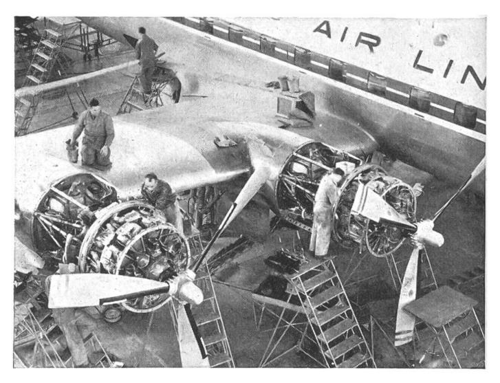
Kontrolle der DC-6B-Motoren in der Flugzeugwerft.
