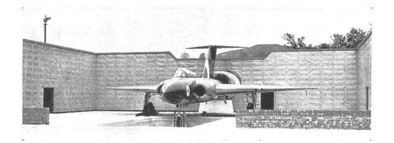
Ein Javelin Düsenjäger in seinem Schallpferch. Hinten an den Triebwerksdüsen ist die Mündung der etwa 20 m langen Schalldämpfer sichtbar.
