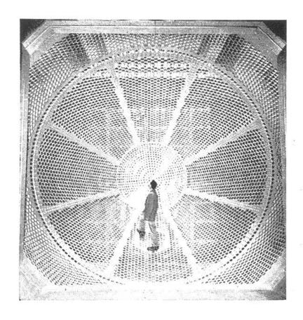
Lärmbekämpfungsprobleme besonderer Art bilden auch moderne Hochgeschwindigkeits-Windkanäle. Das Bild zeigt den Diffusor in einem Kanal für dreifache Schallgeschwindigkeit in den USA. Anschließend dahinter beginnt der eigentliche Schalldämpfer, der dank dem Riesensieb keine Druckstösse erhält, deren Wirkung so gewaltig wäre, dass die ganze Anlage explosionsartig zerstört wür-
