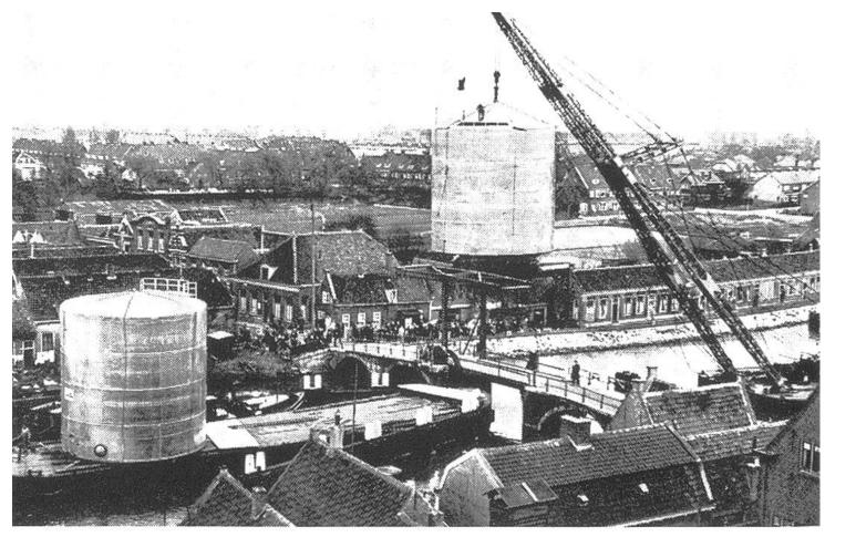
Tanks aus Schweizer Aluminium beim Transport in einem holländischen Kanal. Sie könnten wegen den Pfeilern nicht einmal zwischen dem zu öffnenden Mittelstück der Brücke durch; ein Kran hebt einen Tank nach dem andern darüber, während der Frachter unten durch fährt.
