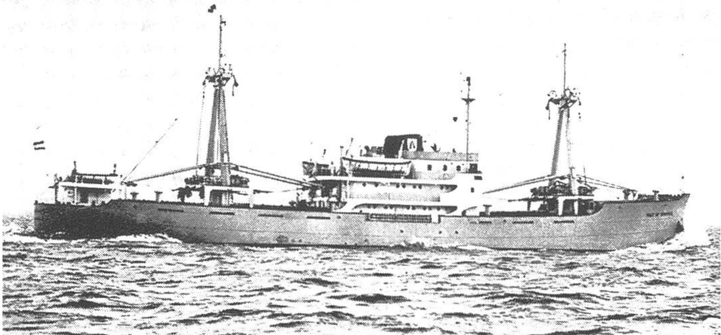
Das französische Frachtschiff M/S Ville de Montréal ist mit einer Antriebsanlage (Dieselmotoren) von 2500 PS der Schweiz. Lokomotiv- und Maschinenfabrik in Winterthur ausgerüstet. Es ist 78,6 m lang, besitzt eine Ladefähigkeit (dw) von 2800 t und wird sowohl im Atlantik als auch auf den kanadischen Seen eingesetzt.
