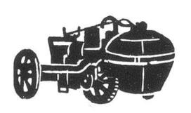
1769 fuhr der erste Dampfmotorwagen, ein Vorläufer der Lokomotiven und Automobile. Der Franzose Cugnot hatte ihn im Auftrag der franz. Regierung für den Transport schwerer Geschütze gebaut; es war ein schweres, dreiräderiges Strassenfuhrwerk, das ungefähr 4 km in der Stunde zurücklegte. Doch schon bei der Probe-
