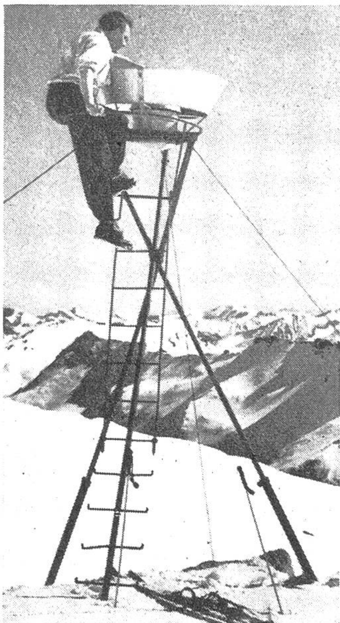
Der Regenmesser wird kontrolliert und geleert, um die Schmelzwassermenge des gefallenen Neuschnees zu bestimmen.
