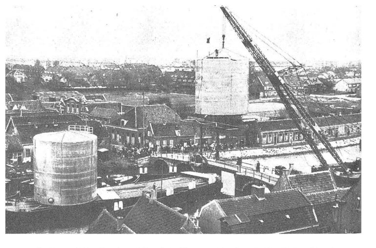
Tanks aus Schweizer Aluminium beim Transport in einem holländischen Kanal. Sie könnten wegen den Pfeilern nicht einmal zwischen dem zu öffnenden Mittelstück der Brücke durch; ein Kran hebt einen Tank nach dem andern darüber, während der Frachter unten durch fährt.
