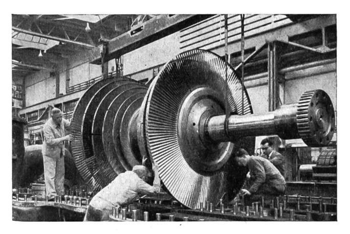
Einsetzen des Niederdruck-Turbinenrades einer 60 000 kW-Dampfturbine.
