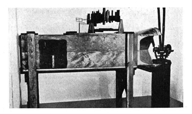
1902: Luftfahrtforschung der Pionierzeit: Windkanal der Gebr. Wright aus einer Seifenkiste und einem an der Schleifscheibe montierten Ventilator! Damit suchten und fanden die Wrights den zum Fliegen geeigneten Flügelquerschnitt, nachdem sie über 200 Modelle untersucht hatten. Durch die Öffnung links konnten die Modellflügel in den Windstrom gebracht und die Luftkräfte gemessen werden.
