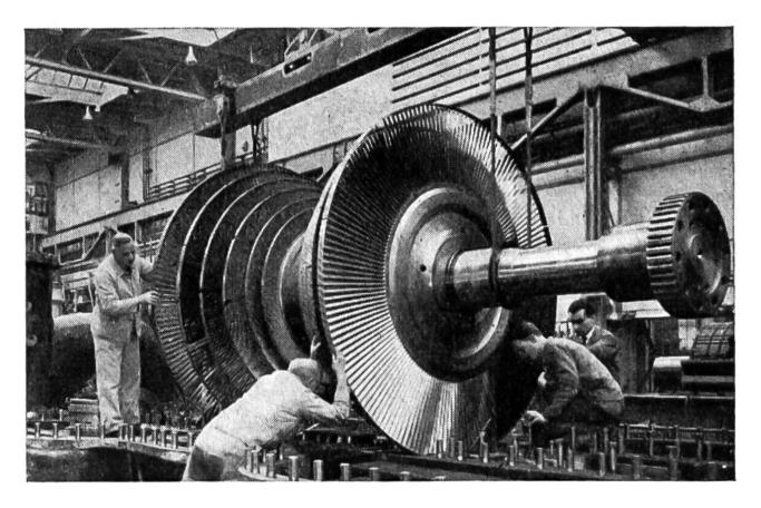
Einsetzen des Niederdruck-Turbinenrades einer 60 000 kW-Dampfturbine.
