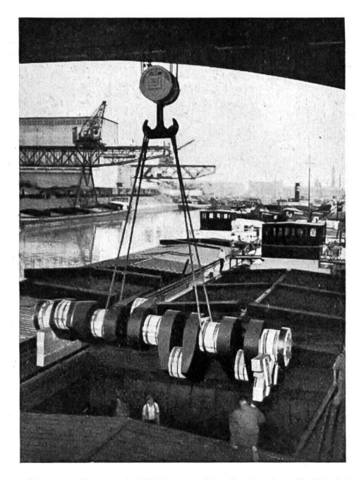
Mit einem Schwergutkran von 65 Tonnen Tragkraft wird die Kurbelwelle für den Dieselmotor eines Seeschiffes zum Transport in einen Meerhafen verladen. Die billige Wasserfracht trägt zur Konkurrenzfähigkeit der schweizerischen Maschinenindustrie wesentlich bei.
