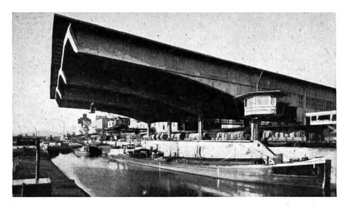
In Kleinhüningen befindet sich die erste Umschlagseinrichtung, anwelcher Schiffe unter einem Dach ein- und ausgeladen werden, so dass auch nässeempfindliche Waren jederzeit umgeschlagen werden können. Von der Kommandokanzel des Hafenmeisters aus (Bildmitte rechts) können die Umschlagsarbeiten überwacht und mittels Lautsprecher dirigiert werden.
