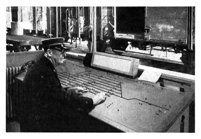
Ein Souschef bedient sitzend das neue elektrische Pult-Stellwerk eines kleineren Bahnhofes.
