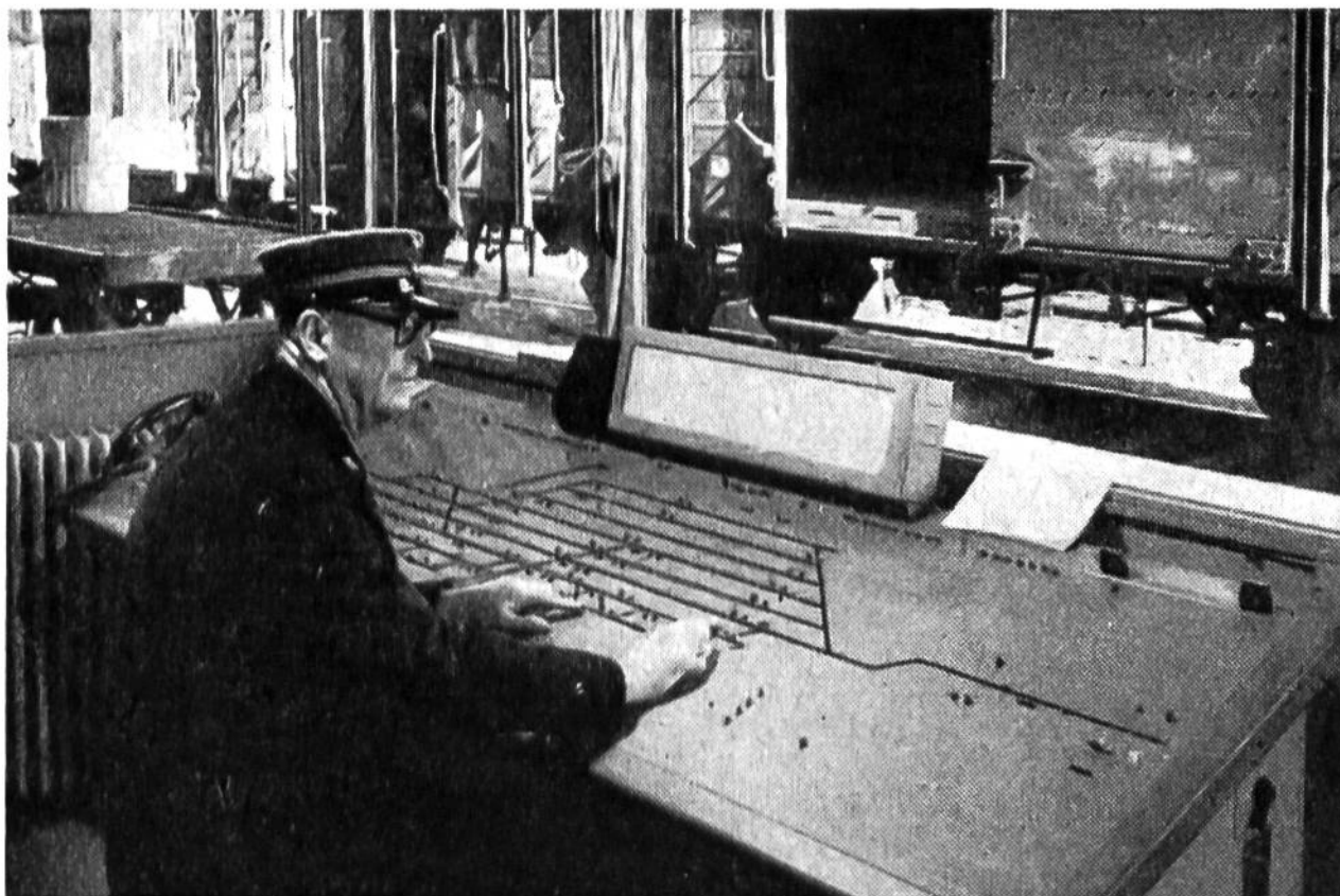
Ein Souschef bedient sitzend das neue elektrische Pult-Stellwerk eines kleineren Bahnhofes.
