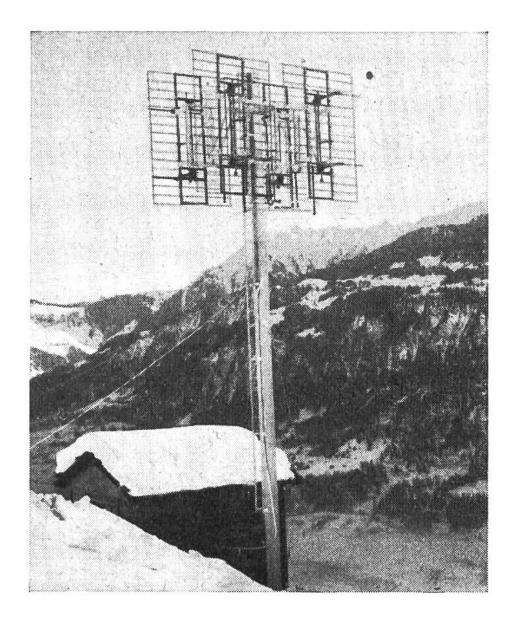
Frequenzmodulierte UKW-Sender werden häufig verwendet, um die Radioprogramme in Gegenden zu verbreiten, wo sonst schlechter **Empfang** herrscht. Unser Bild zeigt den kleinen UKW-Sender Ladir Graubün-(im den) mit seiner Antennenanlage.
