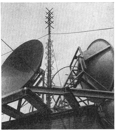
Häufig werden frequenzmodulierte UKW-Radiosender und Fernsehsender an einem Ort gemeinsam errichtet und bedienen sich des gleichen Antennenmastes. Unser Bild zeigt eine Antennenanlage in Köln. Im Hintergrund ist am unteren
