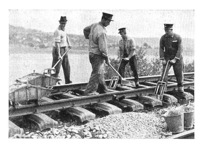
Hier wird das neue Verfahren im Geleiseunterhalt, «gemessener Auftrag» genannt, angewendet. Das Geleise ist vom Schotterbett abgehoben, und mit der besonders konstruierten Schaufel wird der genau bemessene Splittauftrag unter die Schwellen gebracht.
