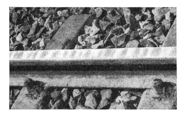
Typische Abnützungserscheinung an der Schiene: die sogenannte Riffelbildung, wellenförmige Unebenheiten der Lauffläche.
