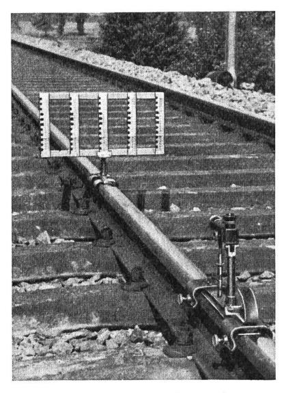
Mit Visierfernrohr und Nivelliertafel werden Mängel in der Höhenlage festgestellt und millimetergenau korrigiert.
