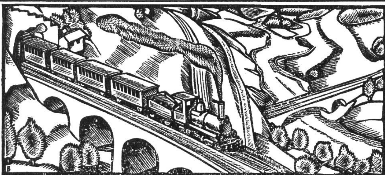
Die 1882 eröffnete Gotthardbahn hat 80 Tunnel und Galerien von zusammen über 46 km Länge und 1234 Brücken und Durchlässe. Sie fährt seit 1920 elektrisch.
