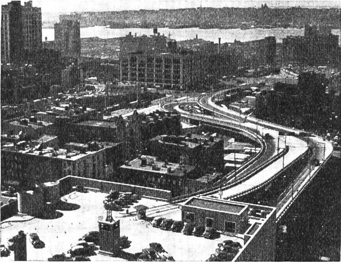
Zu- und Abfahrtsrampen des grossen Autobus-Bahnhofs, dessen Dach im Vordergrund sichtbar ist. Die Strassen führen direkt zum Lincoln-Tunnel, der unter dem Hudsonfluss hindurch nach New Jersey führt.
