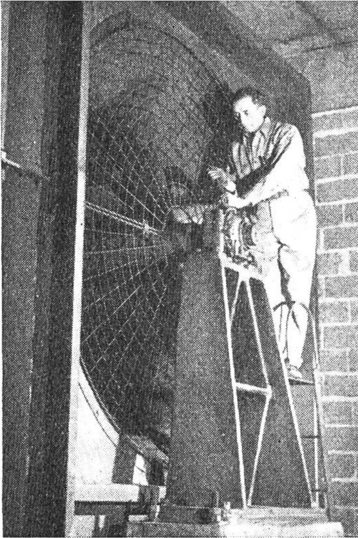
In jedem Stockwerk sorgen riesige Ventilatoren für das rasche Absaugen der gefährlichen Auspuffgase, fahren doch täglich etwa 2500 mit Dieselöl betriebene Autobusse ein und aus.
