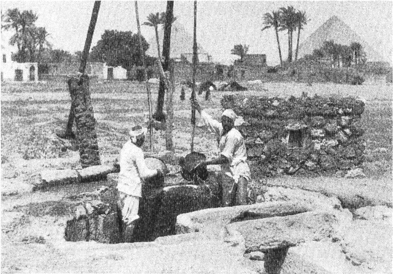
Die Felder erhalten das Wasser nicht aus dem Himmel, sondern aus der Erde: Ziehbrunnen mit Kleinkanälen.
