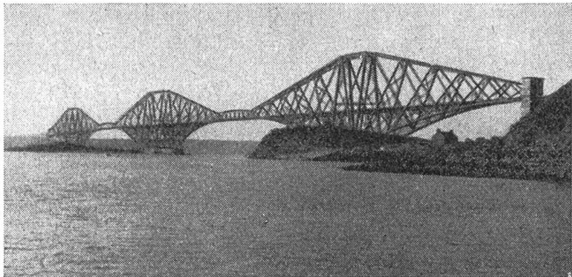
Trotz der massiven Konstruktion macht die Brücke einen überaus eleganten Eindruck. Die Spannweite der mittleren Bogen beträgt je 521 Meter, und die ganze Brücke misst 2466 Meter.
