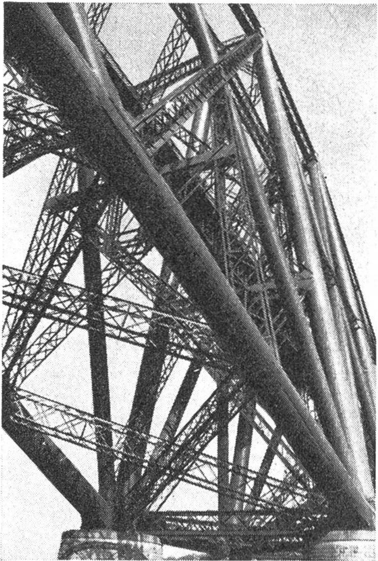
Fast zwei Meter dicke Stahlrohre wurden für den Bau verwendet. Das maximale Ausdehnungsvermögen der gesamten Brücke beträgt 180–215 cm, d. h. durchschnittlich 8 cm auf 100 Meter.
