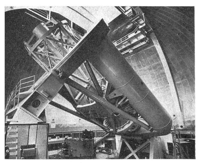
Das riesige Palomar-Spiegelteleskop besteht aus einer rohrförmigen Gitterkonstruktion, an deren unterem Ende der 5-m-Spiegel befestigt ist. Um ihn vor Staub und Beschädigung zu schützen, ist er ausser Gebrauch mit einer Irisblende bedeckt. Das Rohr ruht in einem mächtigen, hufeisenförmigen Lager von 15 m Durchmesser. Der Kessel im Hintergrund auf dem Boden der Sternwarte dient zum Aufdampfen von Aluminium auf die Oberfläche des Glasspiegels.
