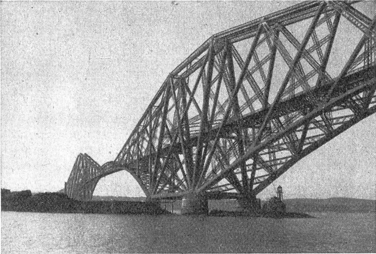
Die mittleren Pfeiler der Forth-Brücke sind auf einer kleinen Felsinsel verankert. Rechts im Bild kann ein kleiner Leuchtturm erkannt werden, der den Schiffen die Brückenpfeiler bezeichnet.
