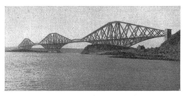
Trotz der massiven Konstruktion macht die Brücke einen überaus eleganten Eindruck. Die Spannweite der mittleren Bogen beträgt je 521 Meter, und die ganze Brücke misst 2466 Meter.
