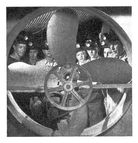
Das ist ein kleiner Ventilationsfächer für den Unterricht. Die grossen Ventilatoren in den Minen treiben pro Minute 2830 m³ frischer Luft in die Stollen des Bergwerks.
