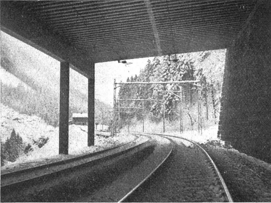
An besonders gefährlichen Stellen wird die Bahn durch Galerien geschützt; die Lawine fegt über diese eigens für sie erstellte Brücke, ohne Schaden zu stiften.
