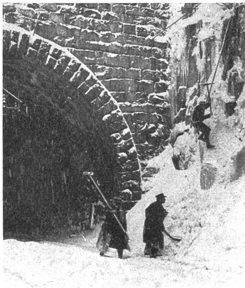
An einem Seil hängend, pickelt ein mutiger Eisenbahner gefährliche Eispartien ab.
