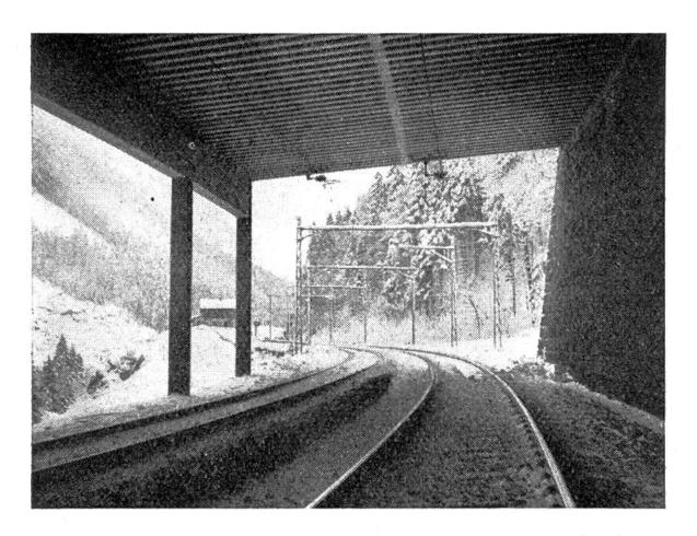
An besonders gefährlichen Stellen wird die Bahn durch Galerien geschützt; die Lawine fegt über diese eigens für sie erstellte Brücke, ohne Schaden zu stiften.
